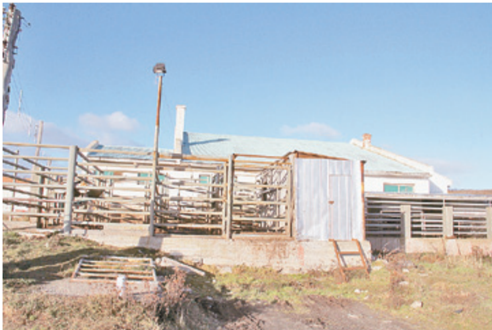
Hay instalaciones que son inamovibles, como los corrales de tubos de acero que muestra la fotografía, que el actual arrendatario, Jorge Oyarzún Fuentes no podrá extraer, por los que pide ser indemnizado.
