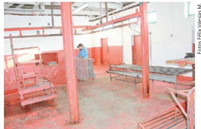
Ayer se observaban obras de desarme y guardado de diversos elementos desde el interior del ex Matadero Koba, el que debe ser restituido al municipio a más tardar el día 15 del presente mes.
