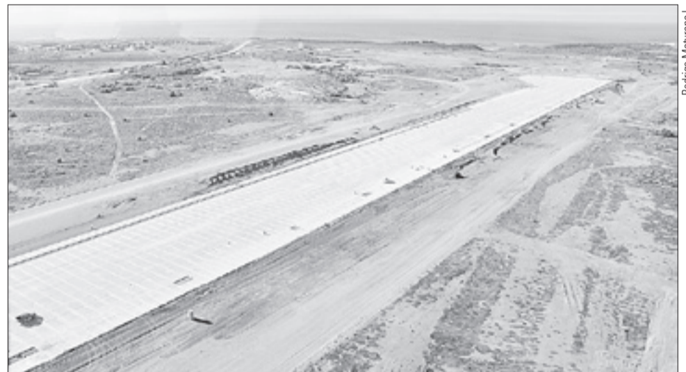
Los trabajos están a cargo de la empresa constructora Excon.
