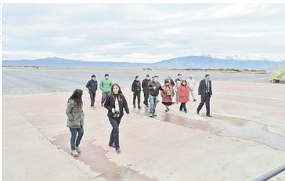
Los trabajos de la pista de aterrizaje concluyeron y consistieron en la prolongación de la pista de 1.760 metros a 2.000 metros de longitud y un ensanche de 30 a 45 metros.
