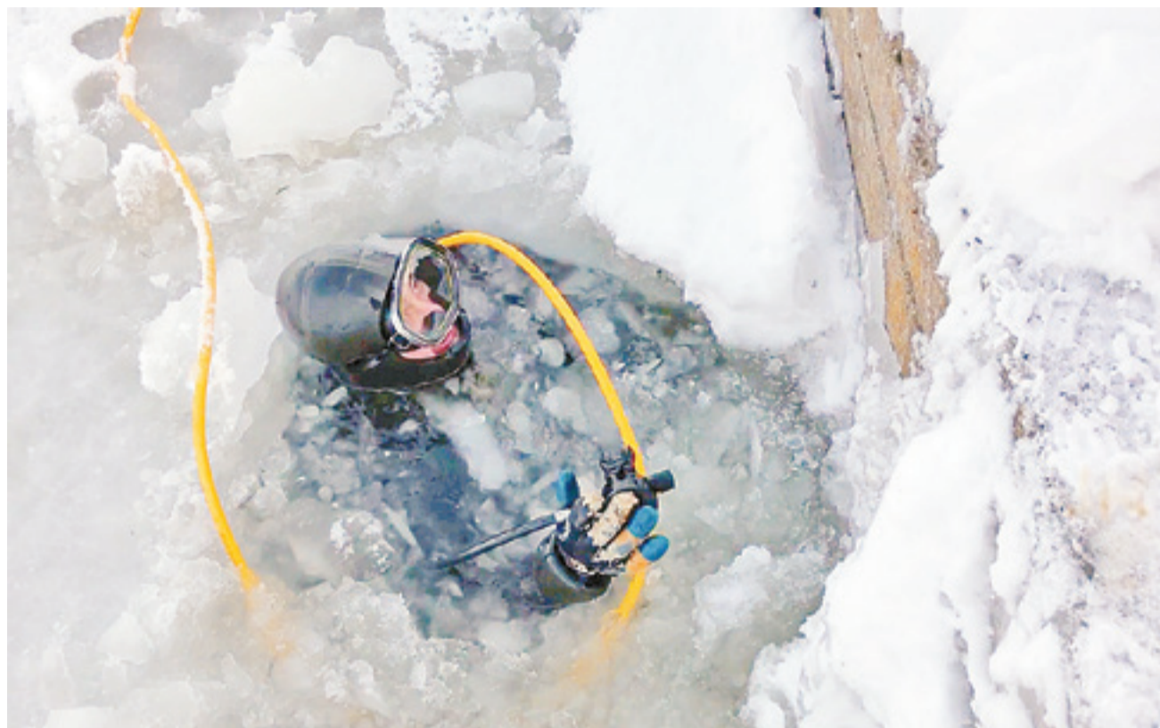
Bajo la espesa capa de hielo, incluso cubierta de nieve, debió trabajar el buzo táctico Víctor González González, para extraer y despejar el "chupador" por el que ingresa el agua que beben los porvenireños.
