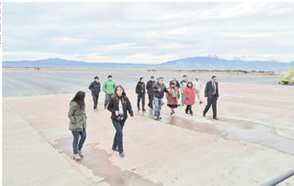
Los trabajos de la pista de aterrizaje concluyeron y consistieron en la prolongación de la pista de 1.760 metros a 2.000 metros de longitud y un ensanche de 30 a 45 metros.
