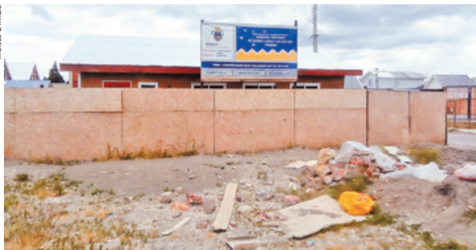
Estado de la construcción de la sede para los dializados en Natales.
