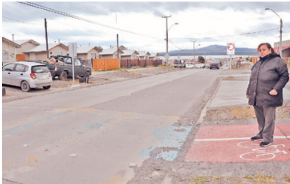
La presidenta de la Junta N° 31 solicita urgente atención por carreras nocturnas. La dirigente muestra un lomo de toro instalado en la Avenida Carlos Ibáñez.
